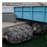
Defensas neumáticas con redes de cadenas y neumáticos Terminal de cruceros Rostock, Alemania (2016)
