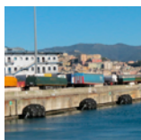
Defensas neumáticas con redes de cadenas y neumáticos Terminal de Ferry Ponto Colombo T7 Génova, Italia (2016)
