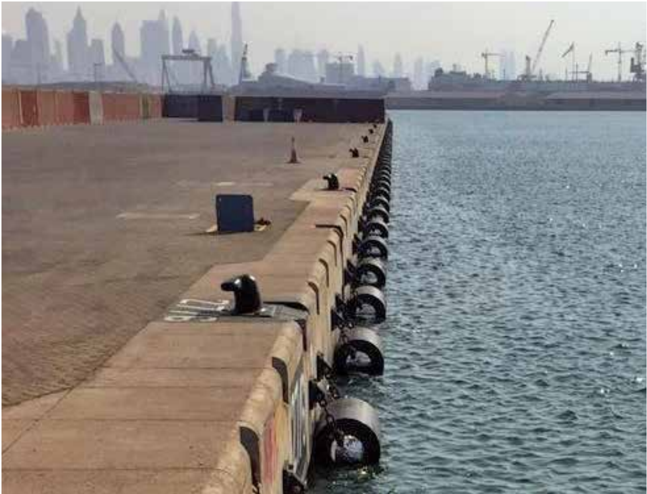
Rashid Port Berth 25 | Dubai | U.A.E.
