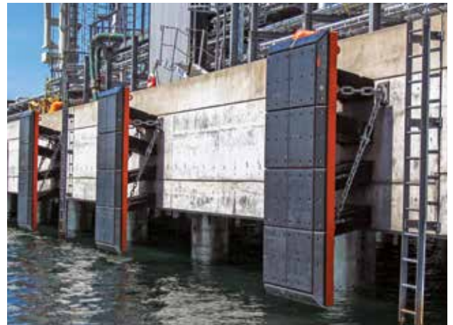
Ethanol Jetty | Stenungsund | Sweden
